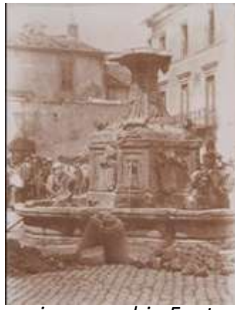
Rimozione vecchia Fontana (Fondazione Besso)
